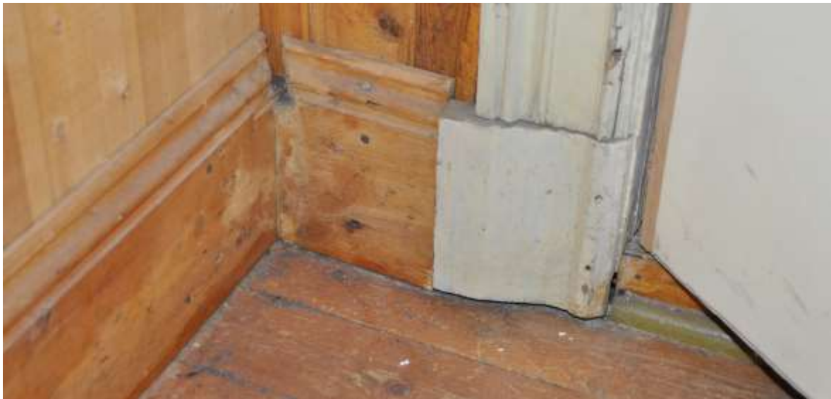
Ursprungligt brädgolv, sockel och foder i en garderob på den övre våningen.
