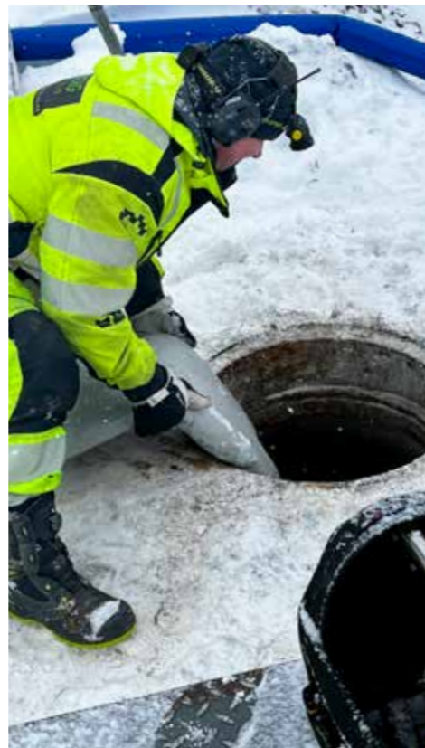
↑ Med relining renoveras rörledningar invändigt i stället för att helt bytas ut. Foto: Jörgen Uusijärvi
