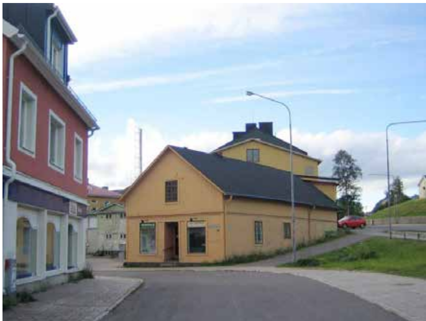
Kv. Cementgutaren 2, Arentgrapegatan 31
