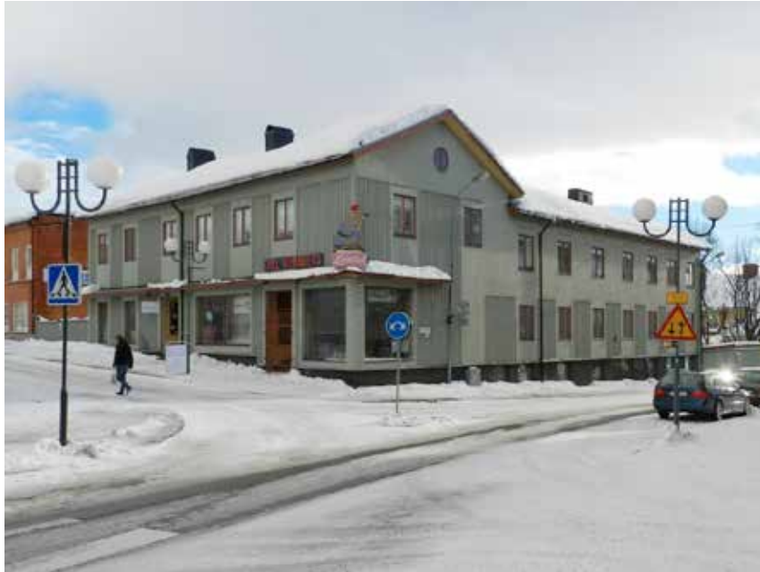
Wennbergs hörna, Kv. Rörläggaren 4, Bergmästargatan 2
