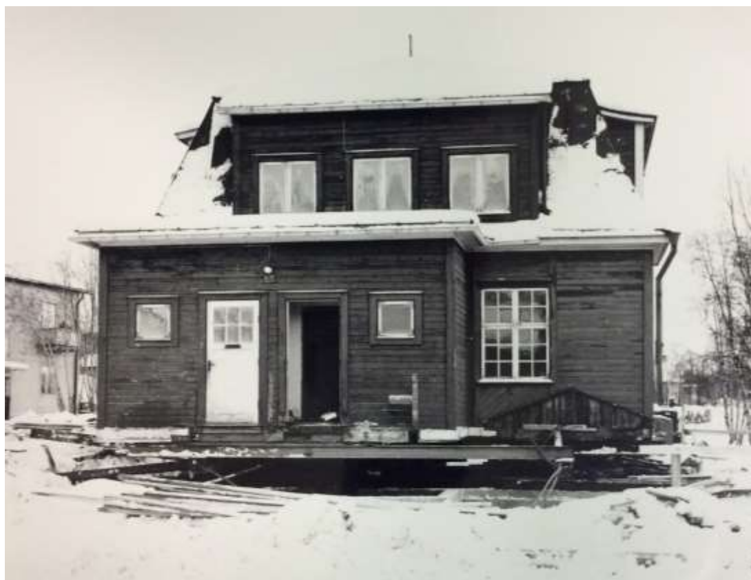
B 52 flyttades 1960. En större takkupa med tre fönster har tillkommit på entrésidan. Förstukvisten har byggts ut till ett vindfång med två entréer. Foto: Kiruna kommuns bildarkiv: 113311.
