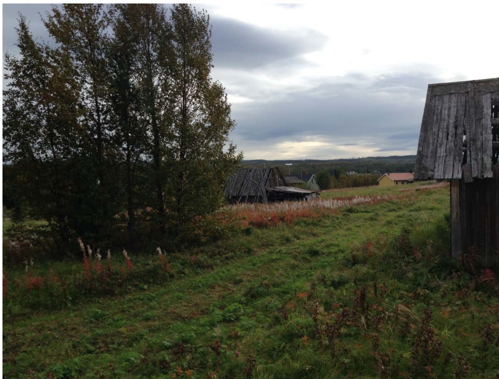
Befintliga lador i ladulandskapet är i behov av upprustning
