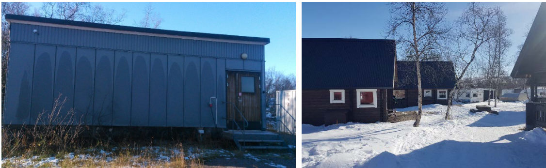
Bild 29-30 Kommunens vattenverk är mitt i detaljplanområdet. Verksamhet flyttas möjligen i framtiden. Byggnaden och omgivningen ser ovårdad ut. Mountain Lodges stugor i anslutningen till detaljplanområdet.
