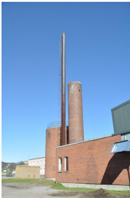
Längst bort i bild oljecisternen, sedan den 25 meter höga skorstenen av corténstål och till höger om denna den 15 meter höga skorstenen som byggdes för oljeeldningen. Längst till höger i bild skymtar en påbyggnad i plåt av en transportör för torv.
