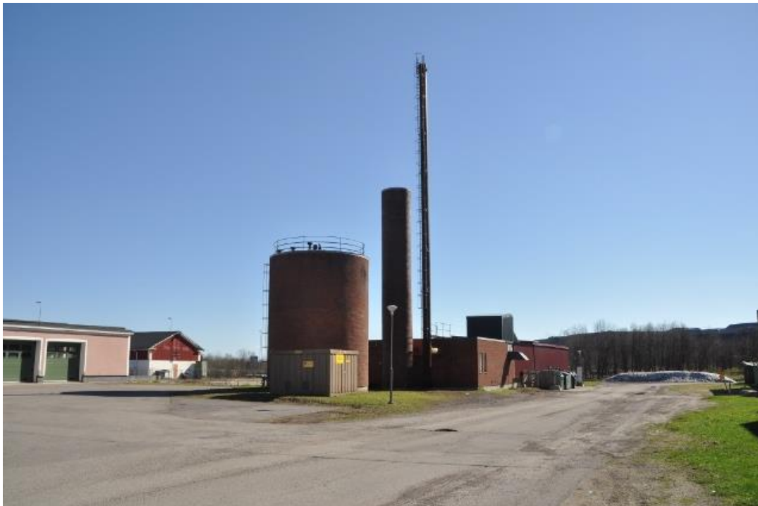
Panncentralen sedd från norr med oljecisternen i fonden.
