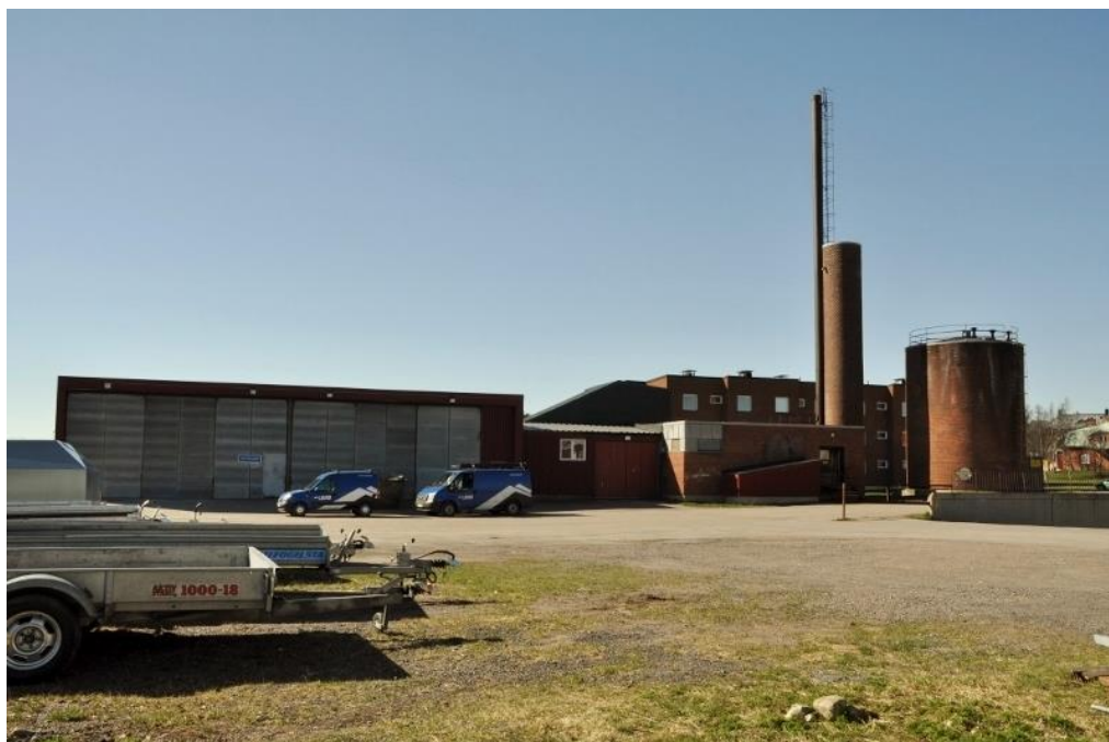
Fasad mot öster med det igenbyggda skärmtaket avsett för containrar med torv till vänster.
