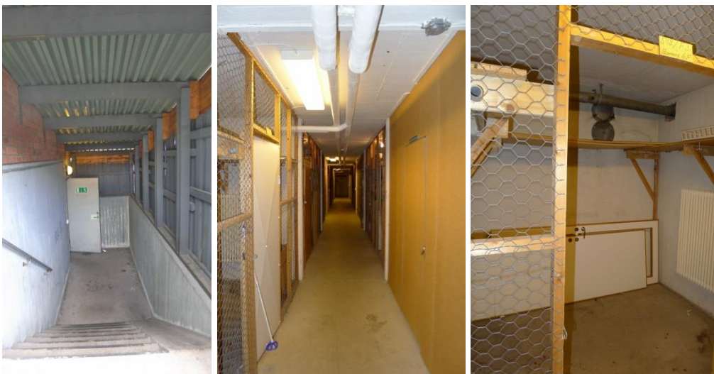
Källarnedgång på östra gavelväggen till hus C1. Förråd och korridor utanför de gemensamma källarförråden. Många glasdörrspartier till vardagsrum återfinns i lägenhetsförråden.
