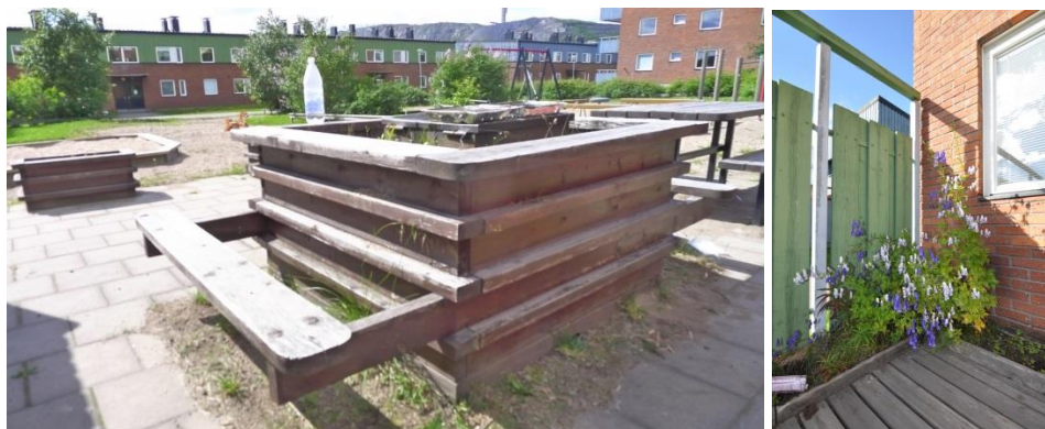
Sittbänkarna och de vindskyddande planken på Ullspiran byggdes enligt Heinz Mais detaljritningar. Först under 1990-talet skall dock utegårdarna ha rustats med grillar.
