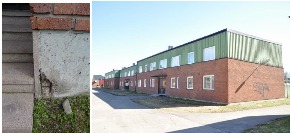
Plansteg i krysshämrad granit på betong, I den gjutna sockeln skymtar armeringsjärn. 6A. Tvåvåningshusen, utan källare, har lägre socklar. T.h. D3-5.
