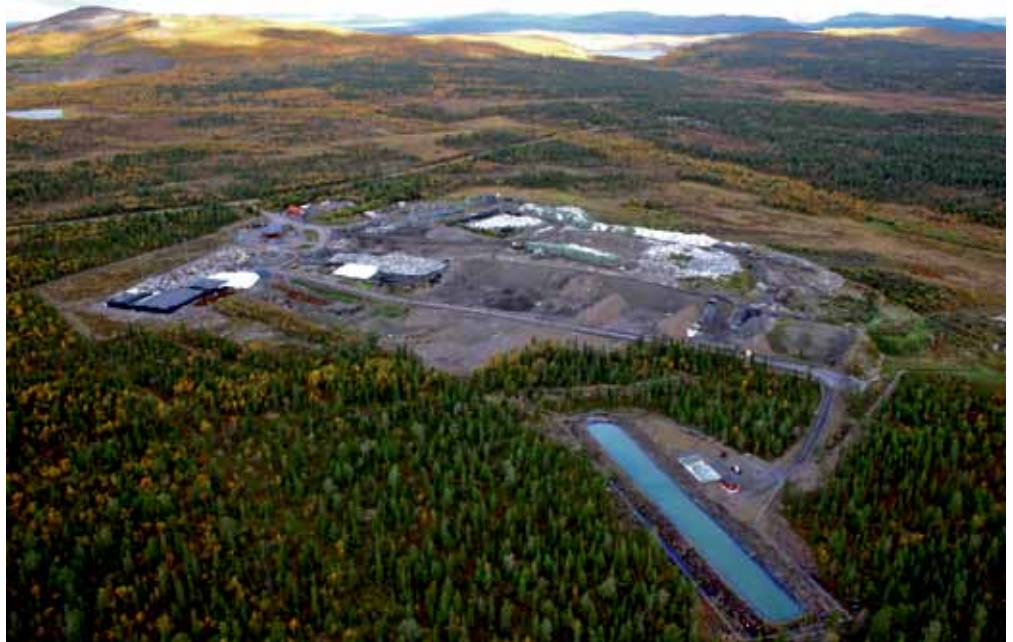
Utbyggd. Avfallsanläggningen i Kiruna har byggts ut för att kunna ta emot förorenad jord.
