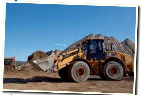
Många vändor med traktorn blir det när 40 000 kubikmeter morän ska flyttas. Foto: Sandra Eriksson
