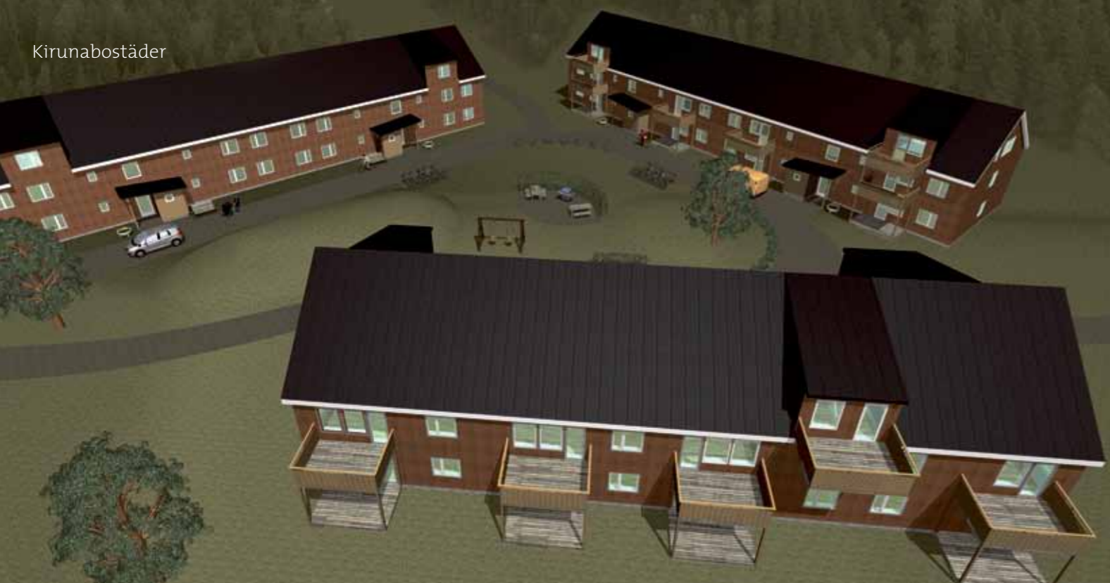
Tre av elva hus som renoveras på nya Glaciären.
