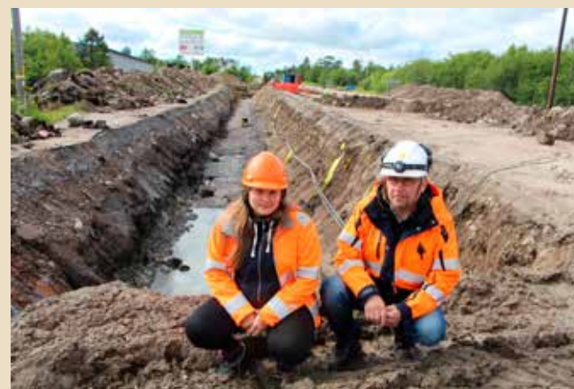
Sara Johansson och Kari Venäläinen , Tekniska Verken, vid de nygrävda schakten.
