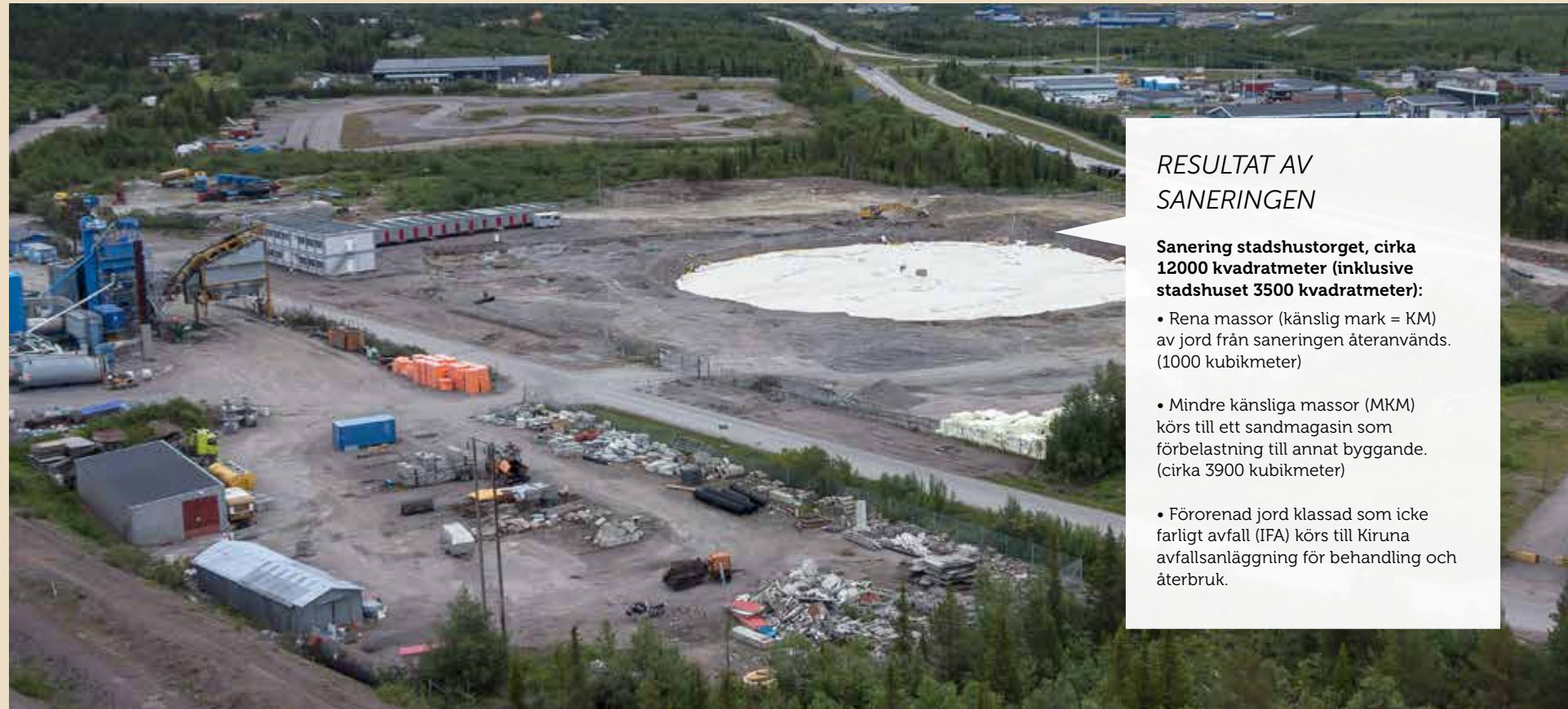
Under saneringen delades torget upp i gropar om tjugo gånger tjugo meter där skikt på en halv meter åt gången sanerades, ner till maximalt två meters djup. Under arbetets gång har en miljökontrollant regelbundet tagit prover av marken.
