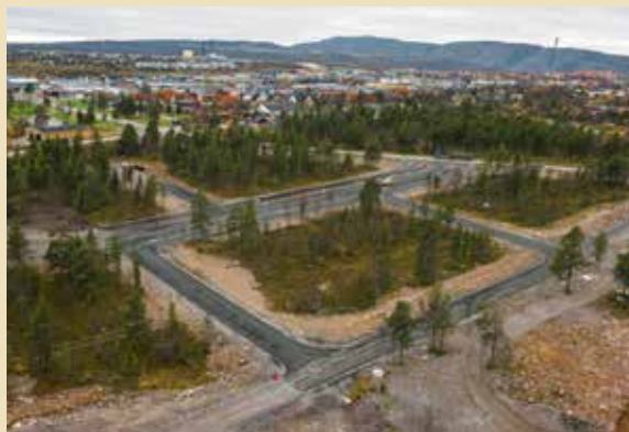
Här bygger Kirunabostäder. I kvarteret i mitten på bilden kommer de två hyreshusen stå.
