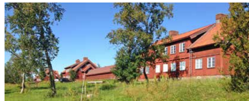
De tre betjäningshusen längs Rälsgatan är uppförda 1910 och kännetecknas av frontespiser, kraftiga framspringande tak över entréer, utsirade vindskivor, små rundbågiga fönster och detaljer i panelen.
