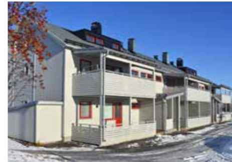
Tallplan 5-6 har renoverats in- och utvändigt.
