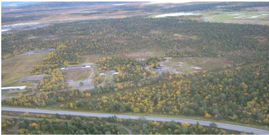
Bild 5.52. Skjutbaneområdet vid Kurravaaravägen. Foto Mats Nilsson.
