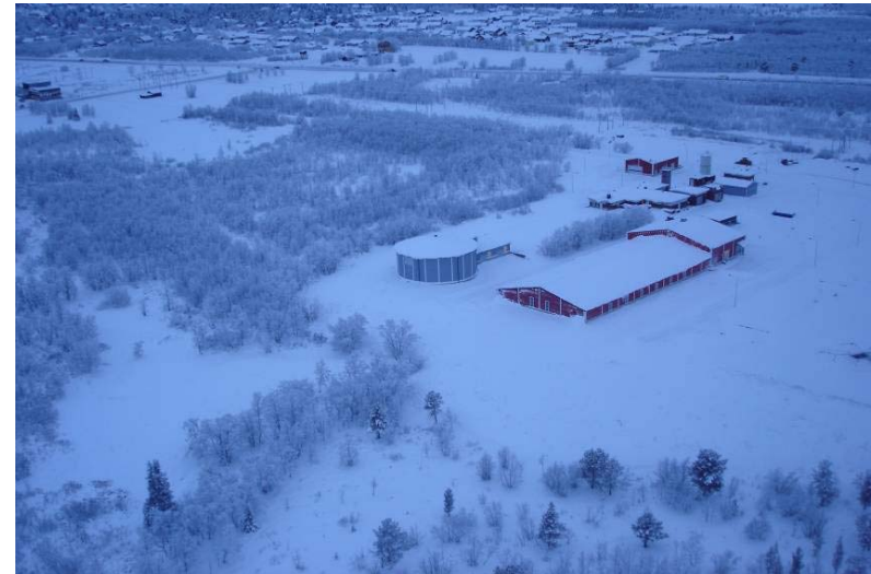
Bild 5.40. Avloppsreningsverket Foto Malin Berglundh Kiruna kommun
