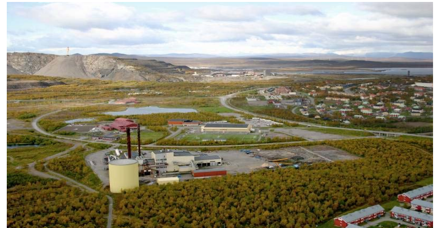
Bild 5.37. Kraftvärmeverket. Foto: Mats Nilsson Kiruna kommun
