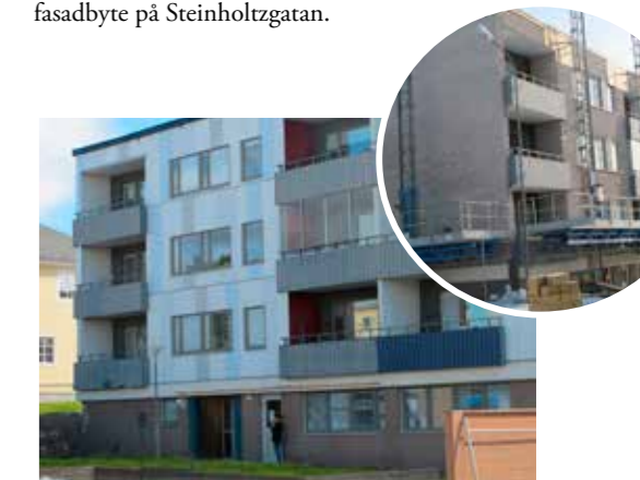
Ny fasad på husen på Steinholtzgatan. Bild uppe till höger visar den gamla fasaden.
