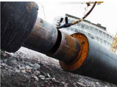
Ny infrastruktur dras fram till den nya stadskärnan. Här ser vi bland annat fjärrvärmelidningen som förser stadshuset med värme.
