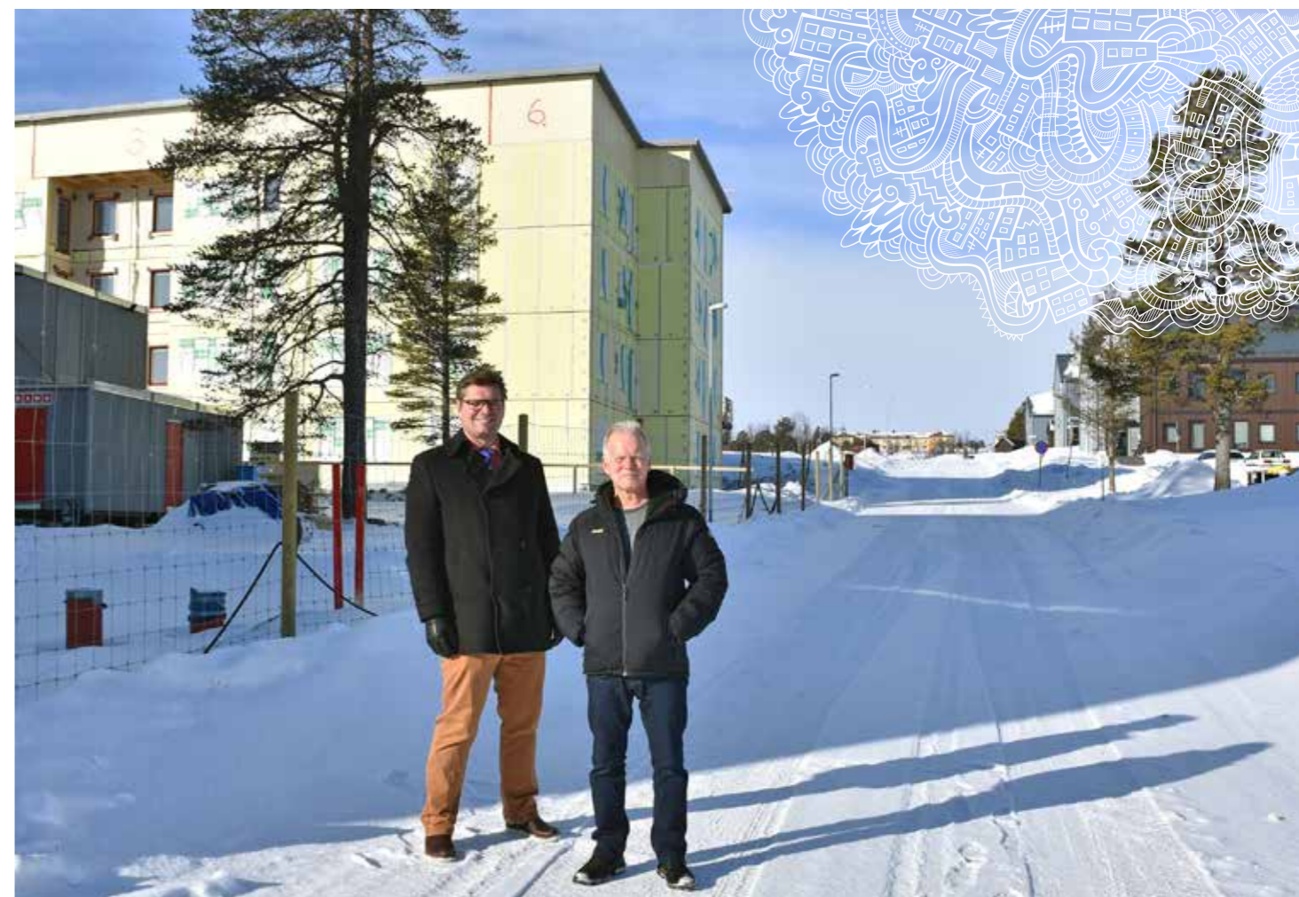
Stefan Sydberg och Mats Dahlberg besöker det pågående bygget av 68 lägenheter på gamla skjutbanan.
