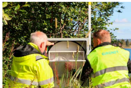
I Svappavaara har det befintliga fibernätet byggts ut under sommarsäsongen. Foto: Moa Strålberg
