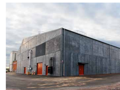
Utbyggnaden av Kirunas vattenverk blev klar under hösten 2022.
