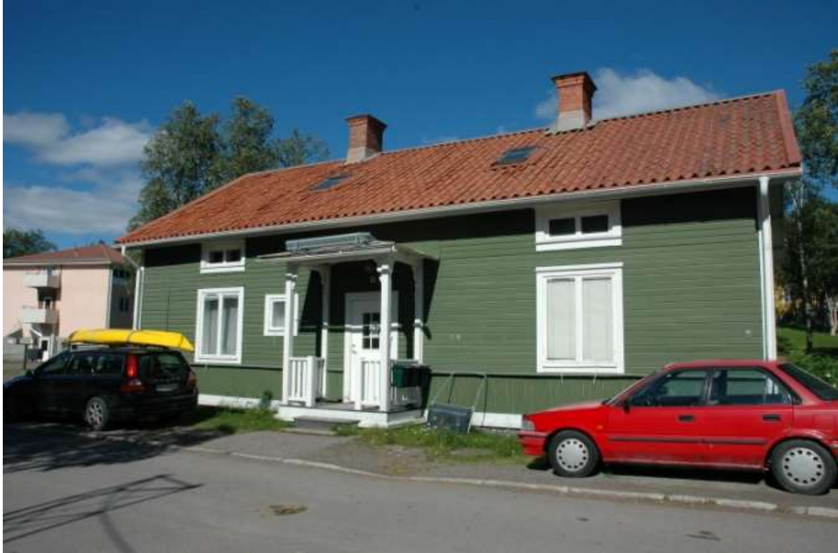
B 5 mot Bromsgatan, augusti 2015. Marknivån har höjts markant och ett av stegen till förstuvisten ligger nu begravt.
