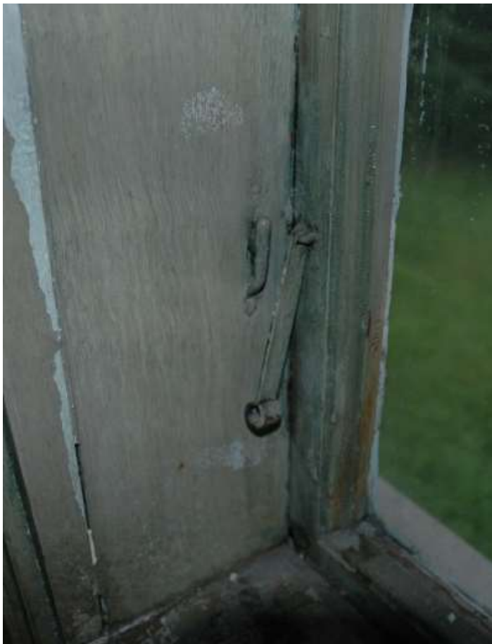
Ursprungliga fönster och fönsterhakar på övre plan.
