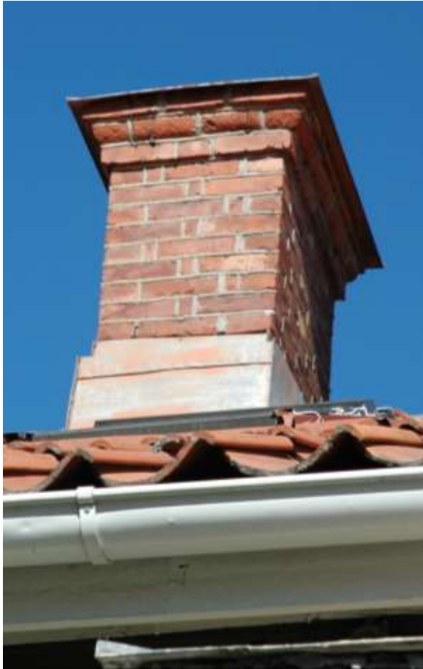
T v: Skorstenarna med originalutförande. Notera det bearbetade krönskiftet. T h: Uthusets äldre bräddörrar.
