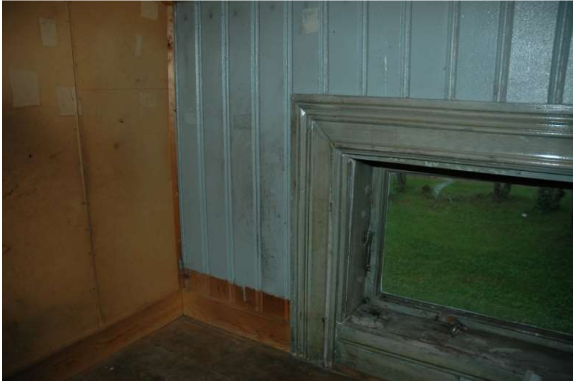
Pärilsponspanel, listverk och fönster i originalutförande.
