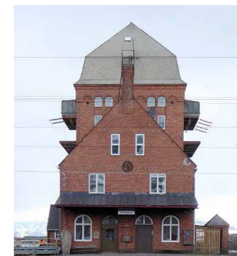
Vassijaure transformatorstation, ett av Kirunas byggnadsminnen.
