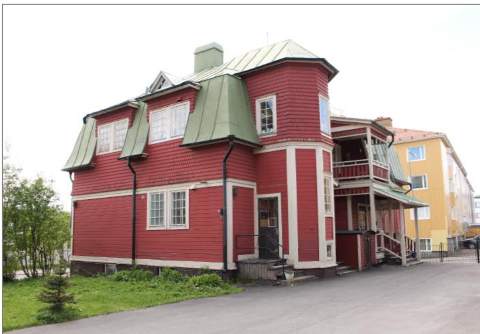
Figur 11. Bostadshus inom Kvarteret Cementgjutaren 1.
