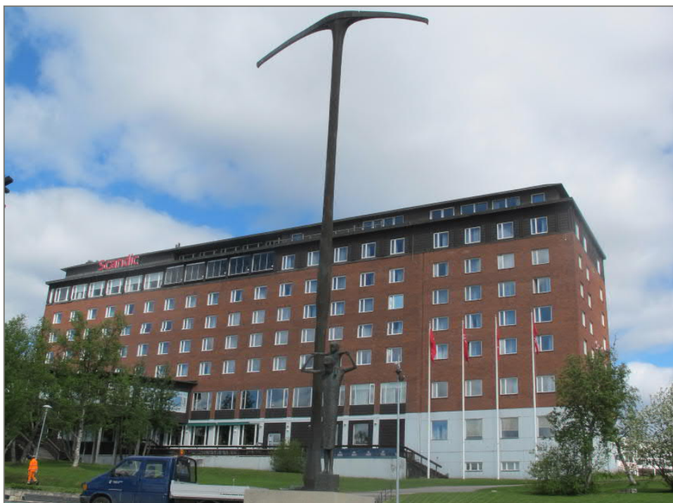
Figur 14. Ferrum uppfördes i samband med centrumsaneringen på 1960-talet.
