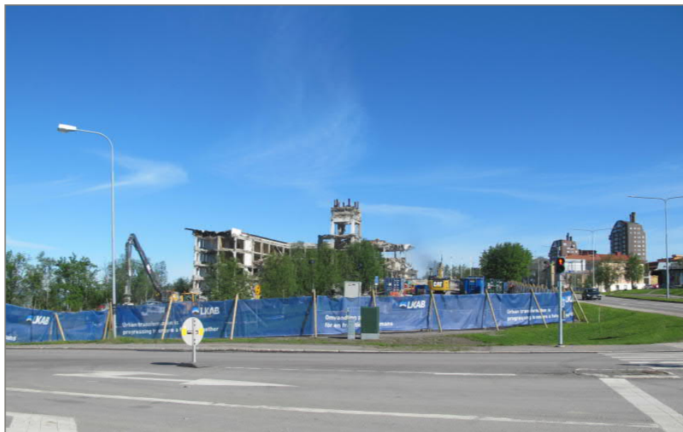
Figur 17. Pågående rivning av Kiruna stadshus våren 2019. Stadshuset ligger inom Gruvstadspark 1. Till höger i bild syns delar av Kvarteret Ort drivaren vilka ingår i Gruvstadspark 2.
