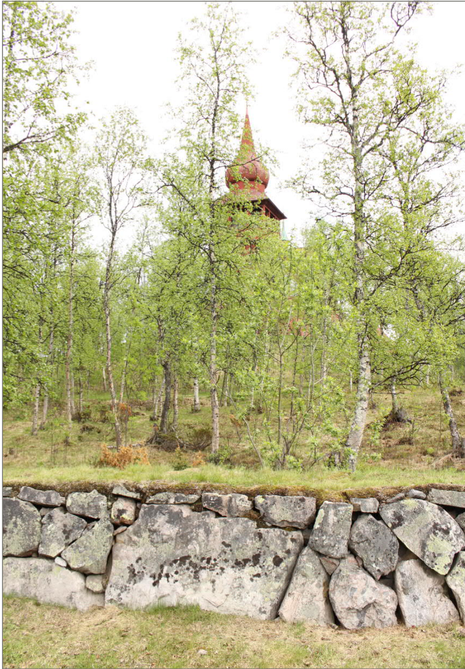
Figur 25. Kyrkoparken omgärdas av en kallmurad stenmur av natursten.
