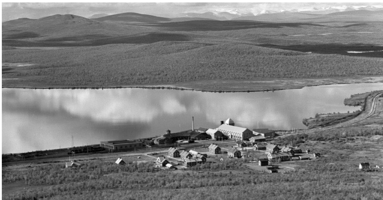
Lokstallsområdet under 1930-1940-talet. I bilden syns flera bostadshus som numera är rivna. Foto: Torsten Dahllöf.
