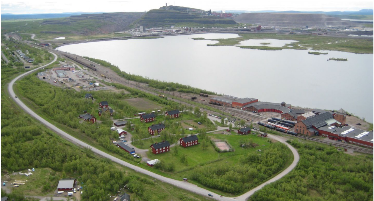
Lokstallsområdet med järnvägen och de gamla lokstallsbyggnaderna i bakgrunden. Källa: Kiruna kommun.
