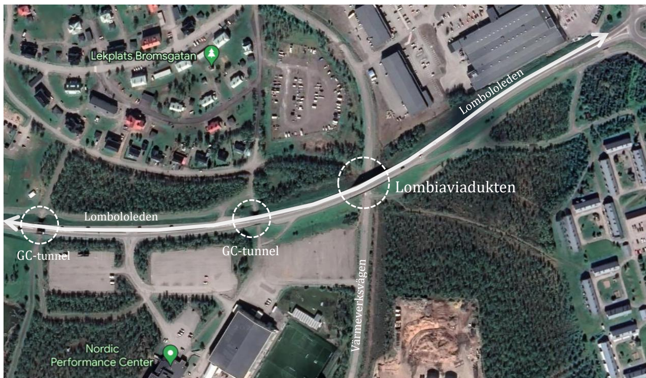
Figur 1, flygfoto visar befintliga viadukter, gång- och cykel-tunnlar och vägar.
