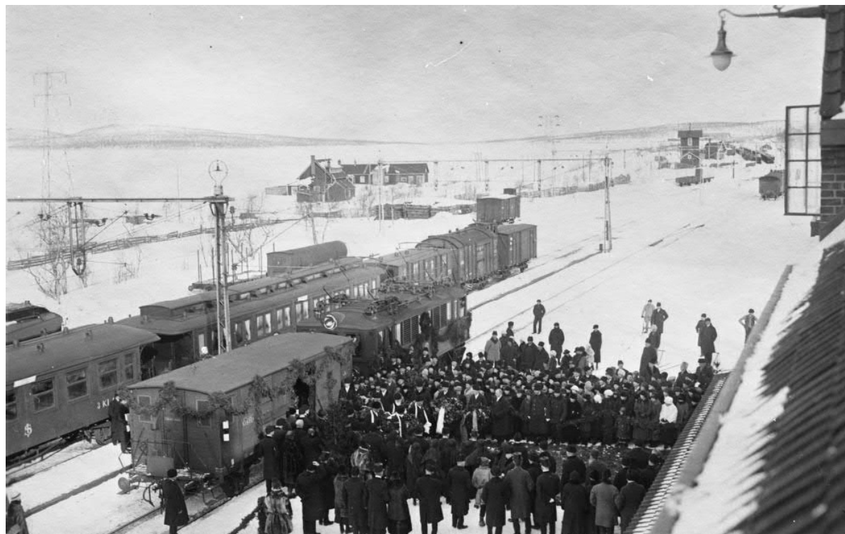
Figur 5.2-7 Hjalmar Lundbohm avled 1926 och efter en begravningscermoni i Stockholm transporterades kistan med tåg till Kiruna. Bilden visar när kistan anländer till Kiruna järnvägsstation.
