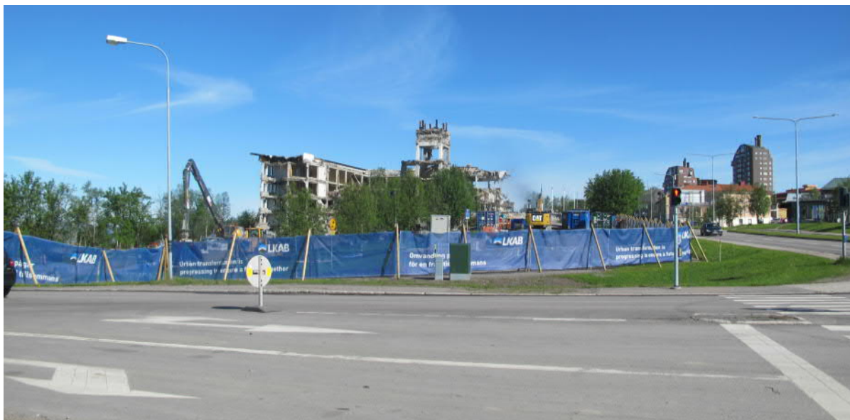
Figur 5.2-1 Rivning av Kiruna stadshus våren 2019. Stadshuset är beläget inom Gruvstadspark 1. Till höger i bild syns delar av karteret Ortdrivaren som ingår i Gruvstadspark 2.
