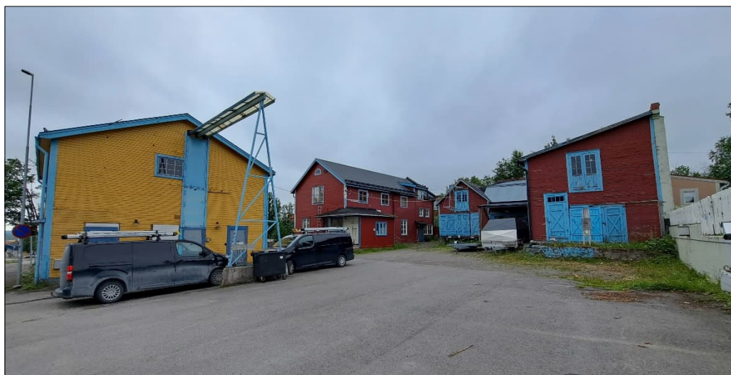
Figur 23. Bebyggelse från tidigt 1900-tal, Kv Malmtapparen. Foto: Anna Högdahl.
