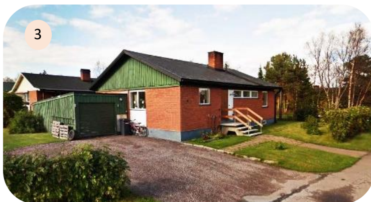
Fältvägen 33 Enplansvilla som representerar 1960-talets villaarkitektur med 25-graders taklutning, låglutande pulpettak med gavelbeslag på garage, röd tegelfasad med gavelspetsar i stående träpanel med tidstypisk färgsättning, murad skorsten, teakdörr utan glas, kvadratiska enlufts-fönster och fönsterband utan fönsteromfattning samt plåttak.
