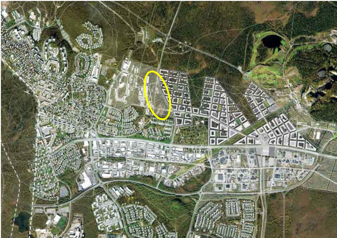
Utdrag ur Kiruna utvecklingsplan. Detaljplanens läge är markerat med gult. Utvecklingsplanen redovisar en huvudgata som löper i öst-västlig riktning från det nya stadstorget. Gatornas läge i planförslaget har anpassats för att möta upp utvecklingsplanen.
