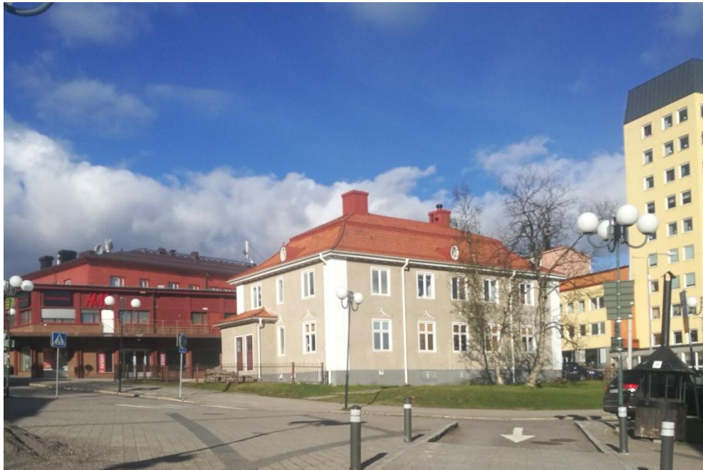
[Pekinghuset vid sin befintliga placering.]
