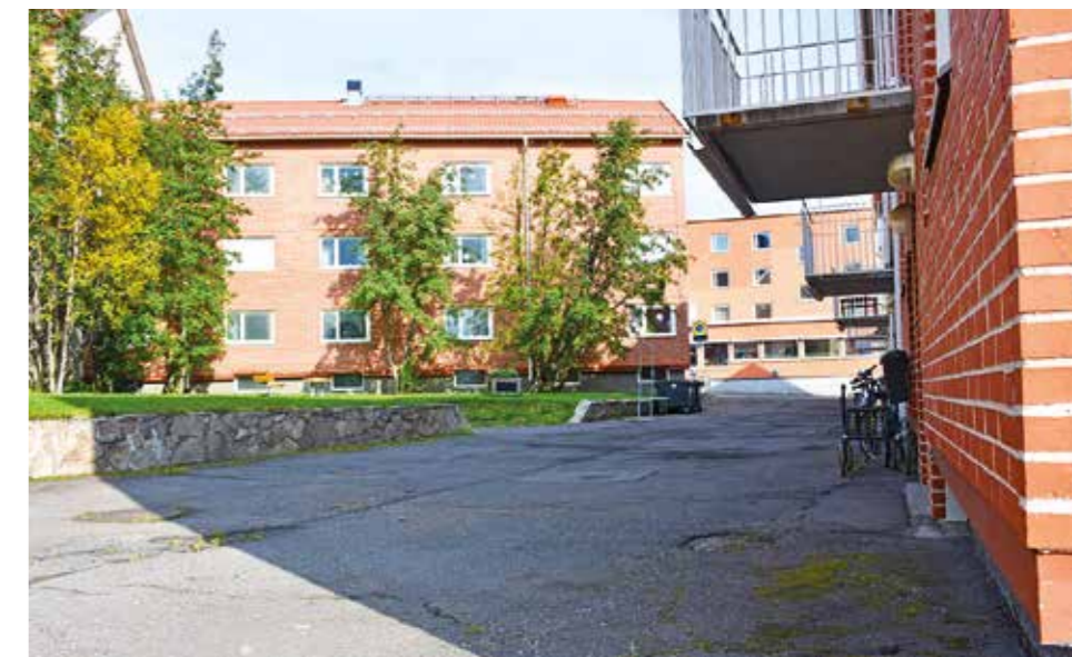
Bergmästaregatan 5 är ett av Kirunabostäders första hus som påverkas av grubvrytningen.
