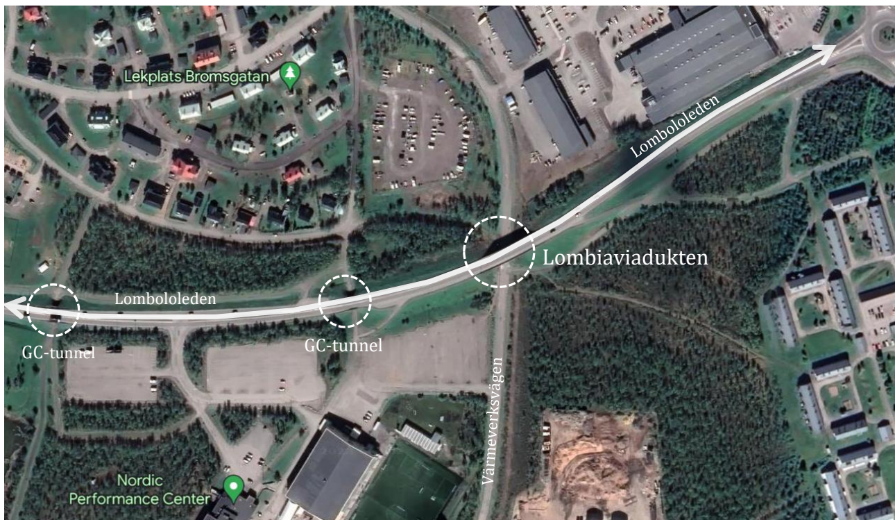
Figur 1, flygfoto visar befintliga viadukt, gång- och cykel-tunnlar och vägar.
