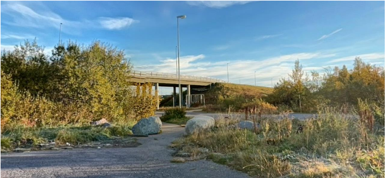
Figur 5, Lombiaviadukten tagen från Värmeverksvägen.
