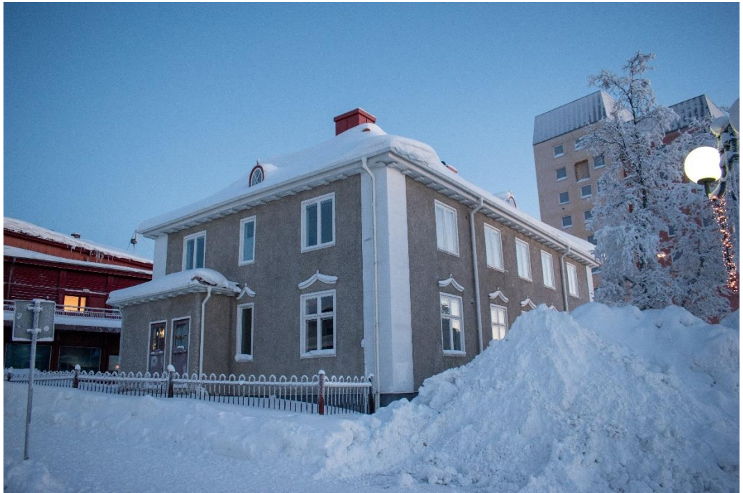
[Pekinghuset vid sin befintliga placering.]
