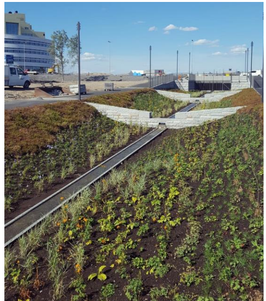
Exempel på öppet dagvattensystem i NKC
