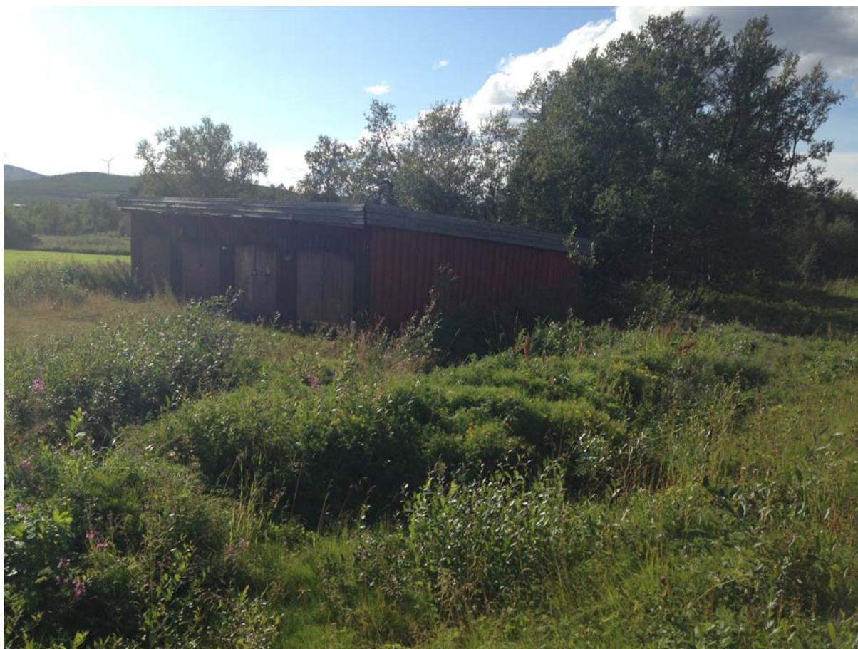
Figur 13. Uthusbyggnad som måste rivas vid planens genomförande.
