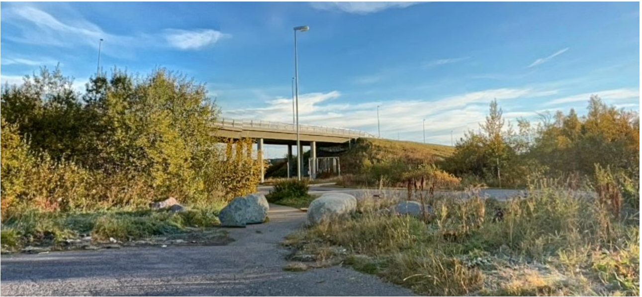
Figur 6, Lombiaviadukten tagen från Värmeverksvägen.
