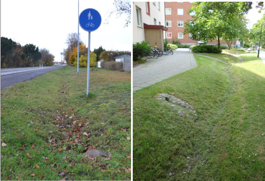
Figur 12. Exempel på diken invid väg och i närhet av byggnader/gångstråk (Bilder: Sweco)
