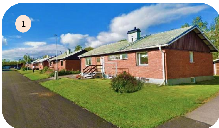
Hagvägen 1-13 Exempel på sammanhållen villa- arkitektur från 1960-talet med vissa tidstypiska karaktärsdrag.
