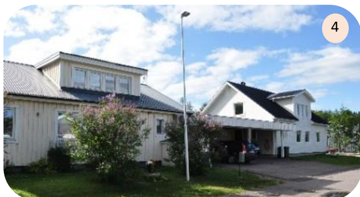
Odlingvägen 20-22 Exempel på småhus med takkupa. Takkupa utförd enligt det främre exemplet inräknas, enligt rätts- praxis, inte i byggnadshöjden medan takkupa utförd enligt det bakre exemplet inräknas i byggnadshöjden. Den bakre takkupan är en s.k. ”Attefallstakkupa”.
