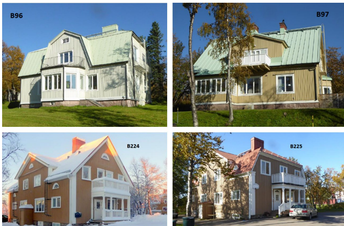
Figur 39. Exempel på några av Björkbackens byggnader som ska flyttas
