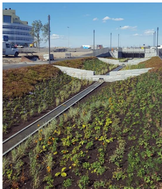
Exempel på öppet dagvattensystem i NKC
