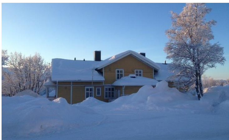
Bild 7. Ett av husen i gula raden. Belägna mellan Hjalmar Lundbohmsvägen och Skolgatan. Foto: Therese Olsson
