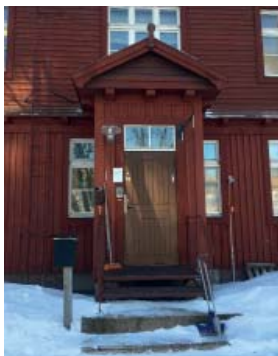
Bild 24. Kontorsbyggnad i SJ-området.
