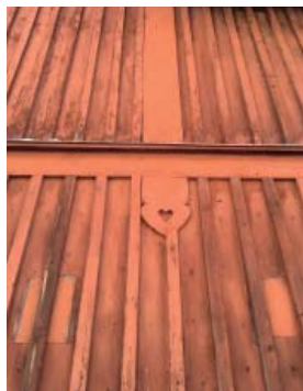
Bild 26. Detalj på fasad i SJ-området.
