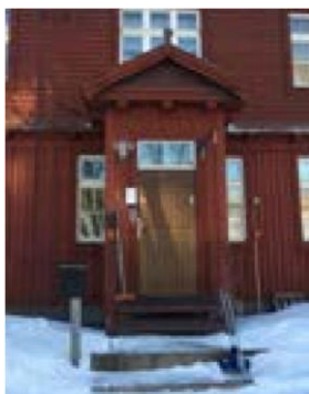
Bild 26. Kontorsbyggnad i SJ-området.
