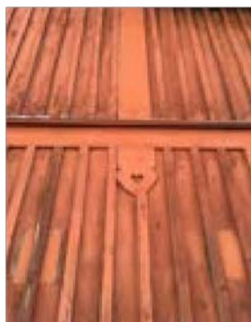
Bild 28. Detalj på fasad i SJ-området.
