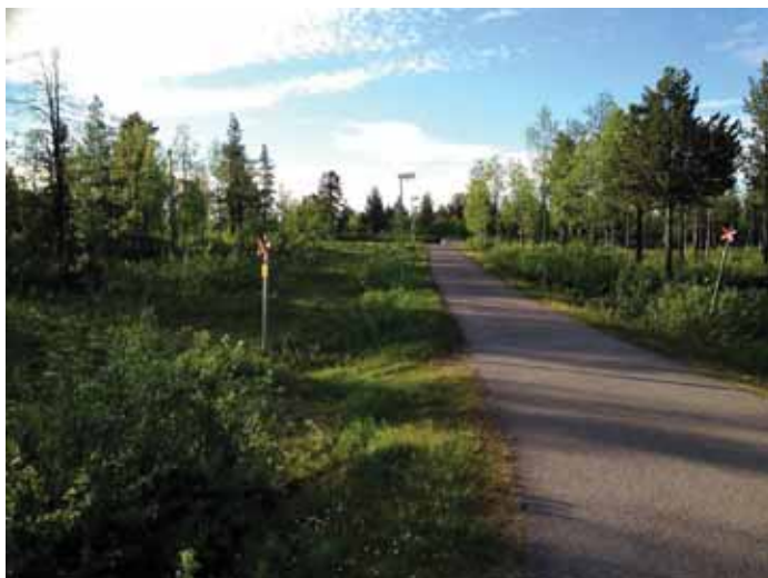
Bild 20. Befintlig gång- och cykelväg mellan korsningen Lastvägen/Industrivägen/Österleden och Malmvägen.
