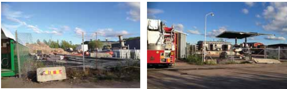
Bild 6-7. Några fastigheter i kvarteren Cisternen vid Lastvägen.
