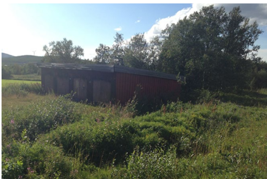
Figur 37. Garagebyggnad som ska rivas. Byggnaden är värderat i januari 2020.
