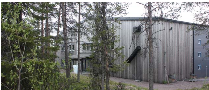
Foto från Marknadsvägen mot befintlig "ishall".
