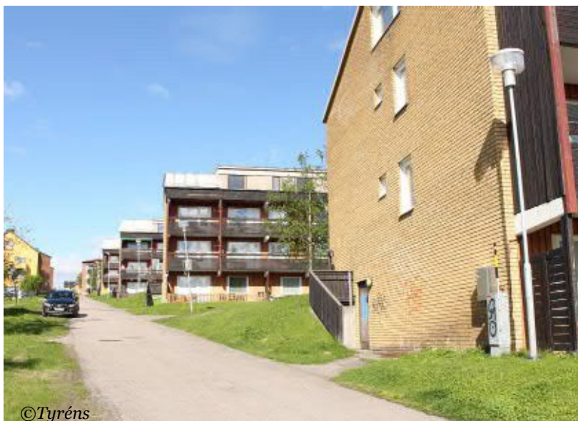
Figur 20. Vy upp mot Tågmästaregatan med hus tillhörande Konduktörsgatan till höger.
