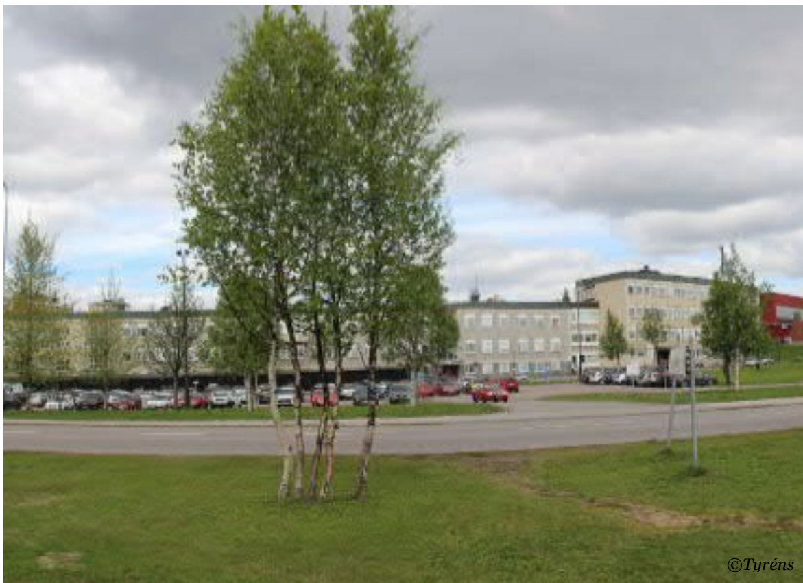
Figur 14. Del av Parkskolan och del av badhuset, till höger i bild, sett från gångstig vid kyrkan med Gruvvägen i fonden.
